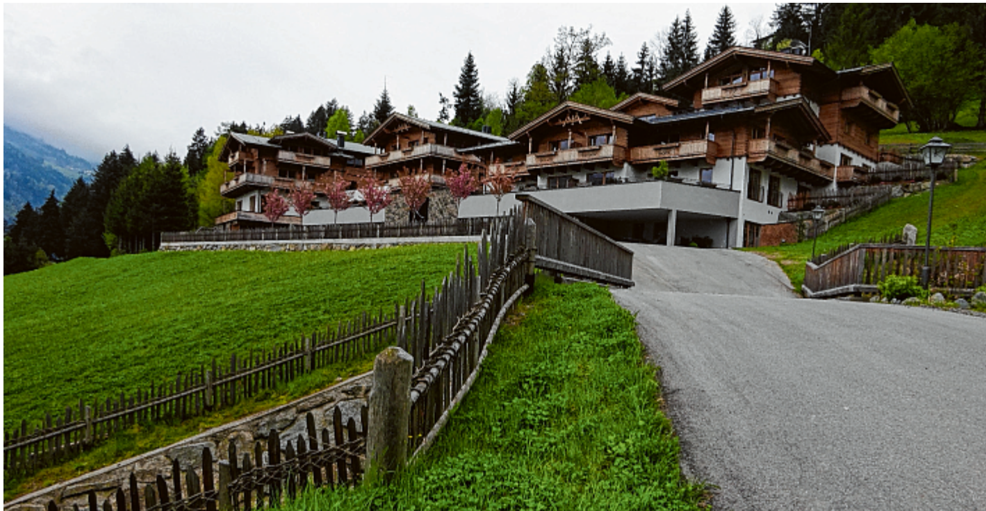
Die Zufahrt zu dem Hotel beim Reisachbach ist wasserrechtlich nicht bewilligt, die Behörde fordert seit Monaten den Rückbau. Foto: Dähling
