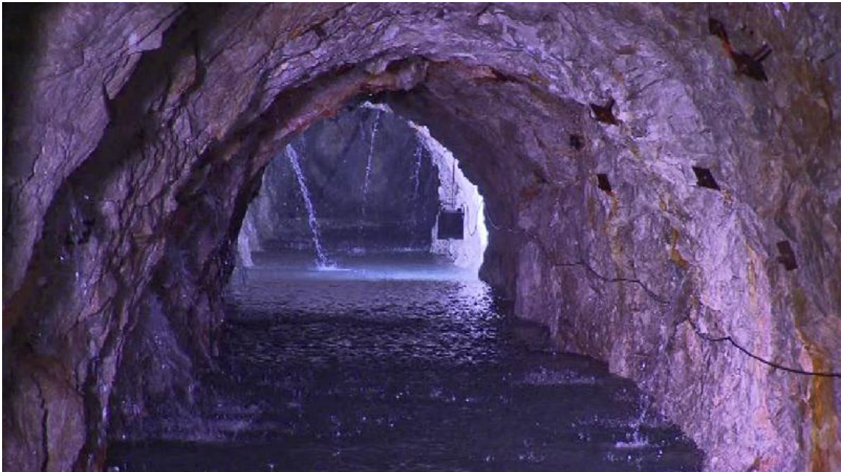
Das Wasser fließt aus dem wasserführenden Berg in den Trinkwasserstollen
