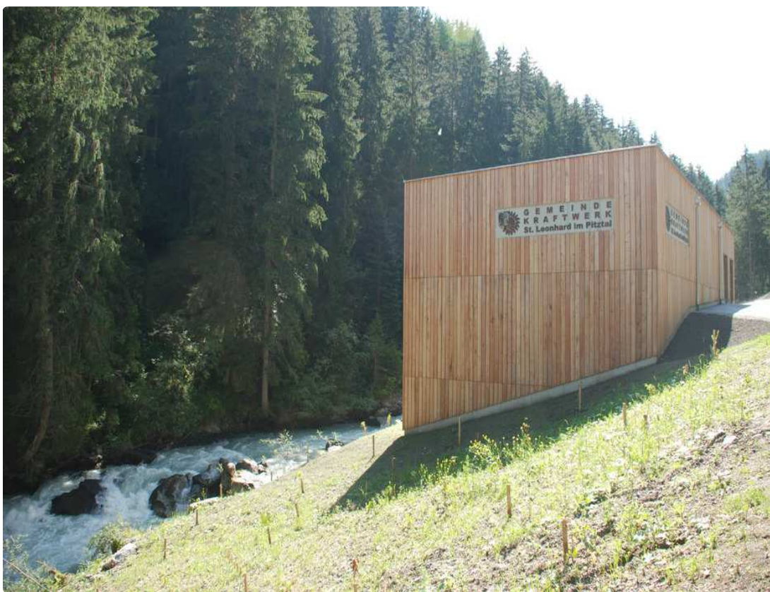
Hier am Wehr in Scheibrand sollten künftig vier Kubikmeter pro Sekunde in den Druckstollen fließen. © Paschinger Fotos: Paschinger
