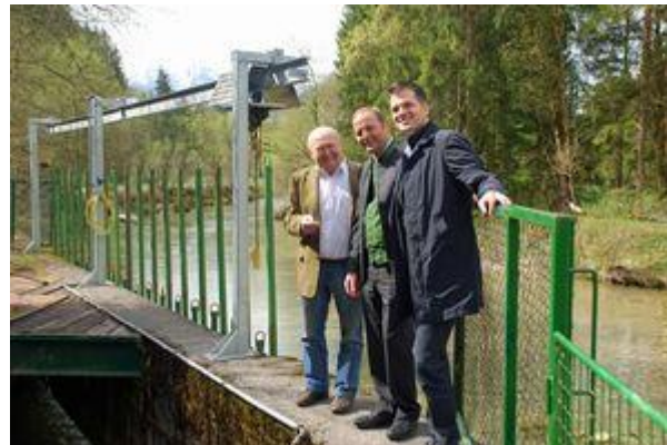
Durch die Erneuerung des bestehenden Kleinkraftwerkes am Kohlenbach konnte die Energieerzeugung verdreifacht werden. (v.li.) Rupert Ebenbichler von der Wasser Tirol, der Kraftwerksbetreiber Hans Ebersberger und Energielandesrat Josef Geisler.
