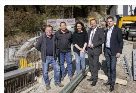
Die Revitalisierung © Land Tirol/Die Fotografen der Kleinwasserkraft am Schlickerbach ist voll im Gange. Karl Gleirscher und Leo Span, Ingrid Felipe, Josef Geisler und Rupert Ebenbichler besichtigten gestern die Baustelle (v. l.).
