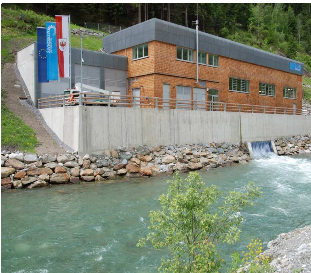
Das Kraftwerk Stanzertal wurde um 58 Millionen Euro errichtet, der Strommarkt wirbelt derzeit die Kalkulationen der Betreiber durcheinander. Die Gemeinden stehen unter Druck. Foto: Wenzel
